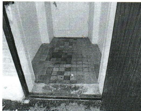
Фото № 4 Входной проём в ДОУ
