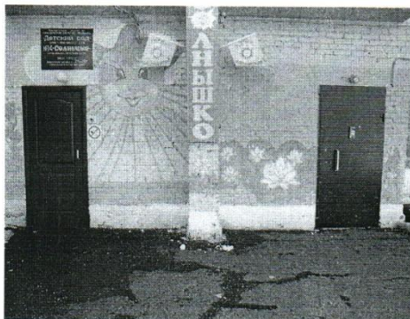
Фото № 3 Входная дверь в ДОУ
