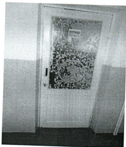
Фото № 7 Стеклопанельная дверь внутри ДОУ
